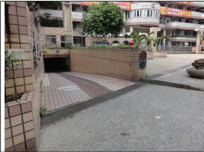
地下停車場車道入口
