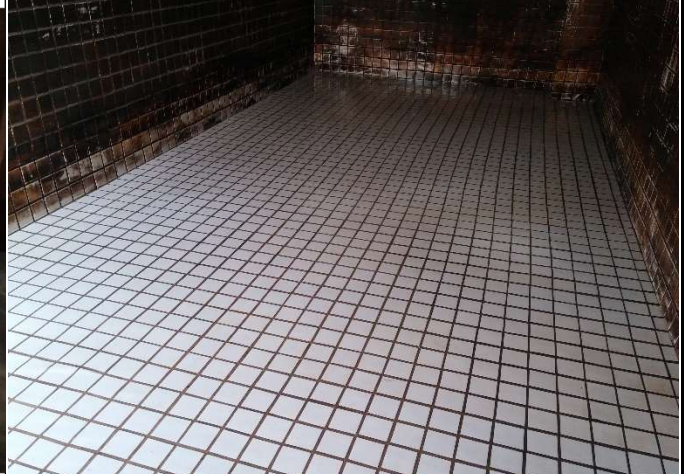
說明：三綱樓蓄水池清洗後
