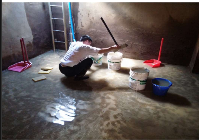
說明：四維樓蓄水池清洗作業
