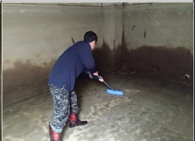
說明：校園水塔清洗作業
