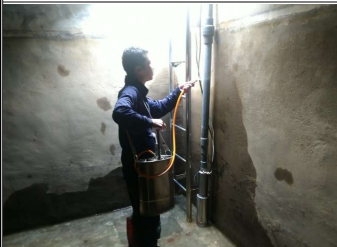
說明：校園水塔清洗作業
