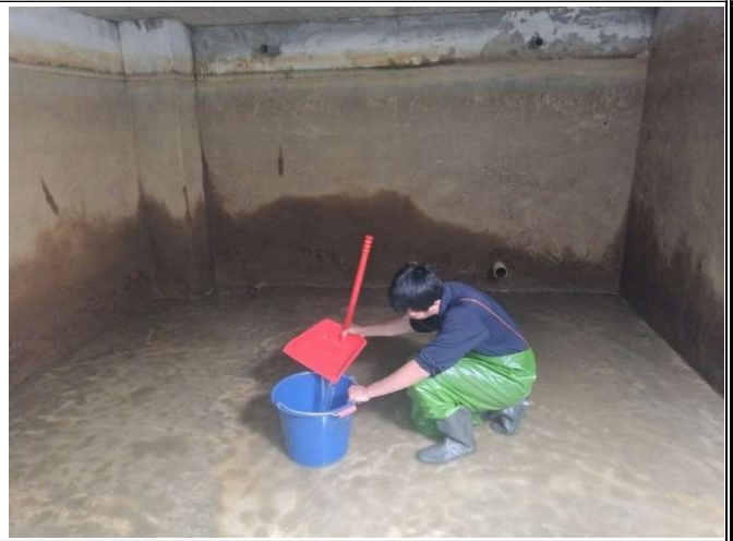
說明：活動中心蓄水池清洗作業
