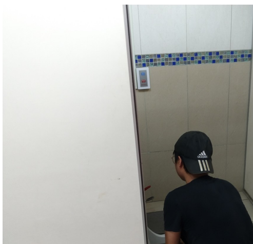
說明：蹲式廁所進行除垢清潔作業
