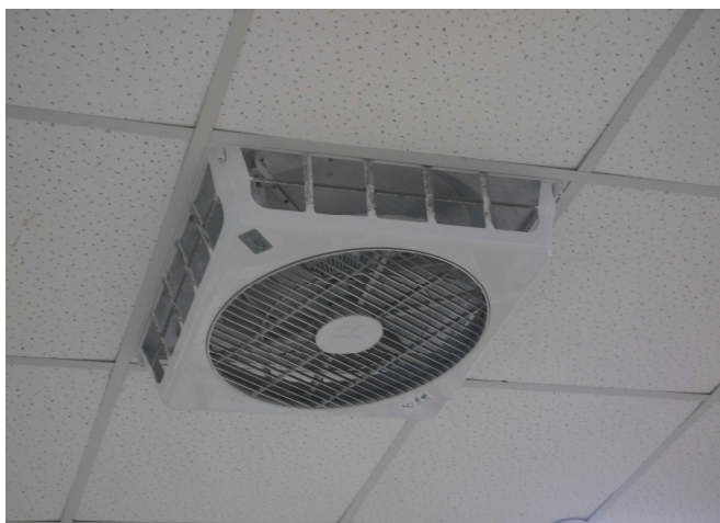
說明：更新一般教室天花板風扇
