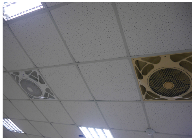
說明：增設一般教室天花板風扇
