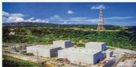
核能發電廠(核一廠)
