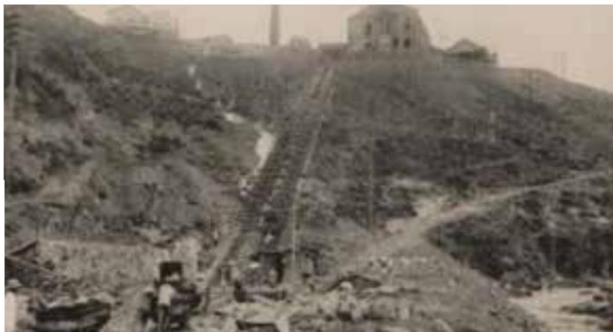
▲金瓜石礦區內的運送軌道。（圖片來源：《金瓜石礦山寫真帖》）
